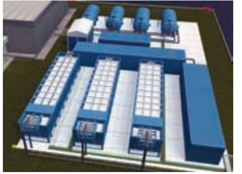
Paket Su Arıtma Tesisi (500 m 3 /sa)
