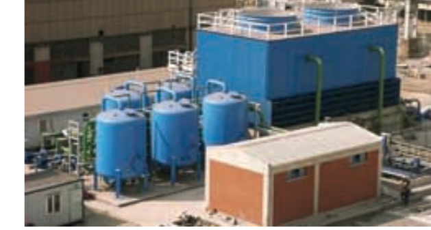
Iskenderun Çelik Fabrikası Proses Suyu Üretim Tesisi
