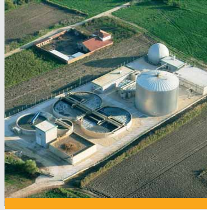
Süttaş-Karacabey Süt İşleme Fabrikası Atık Su Arıtma Tesisi-Bursa, Türkiye Kapasite: 3.500 m 3 /gün, KOL Yüğü: 21.000 kg/gün
