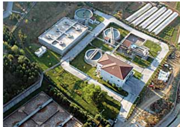
Besler Gıda Bitkisel Yağ Fabrikası Atık Su Arıtma Tesisi - İstanbul, Türkiye (Kapasite: 12.000kgKOl/gün, 100.000 E.N.)
