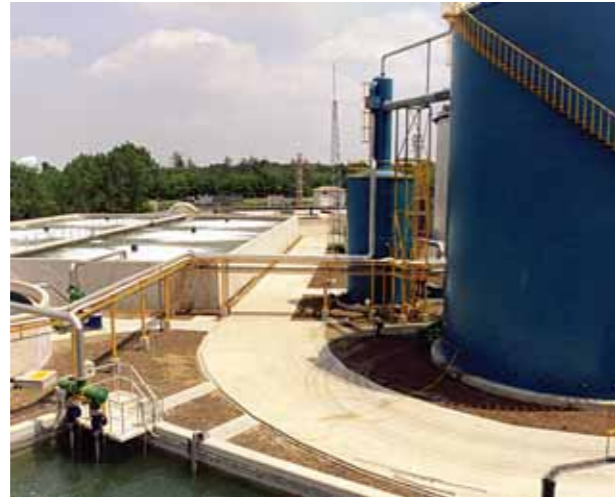
Modern Karton Hamur ve Kağıt Fabrikası Atık Su Arıtma Tesisi - Corlu, Türkiye (Kapasite: 40.000 kgKOl/gün, 330.000 E.N.)
