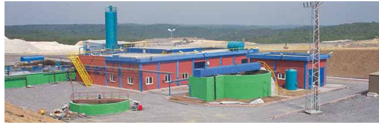
İstanbul Belediyesi Sızıntı Suyu Arıtma Tesisi, Kömürcüoda - İstanbul (Kapasite: 30.000 kgKOL/gün, 250.000 E.N.)
