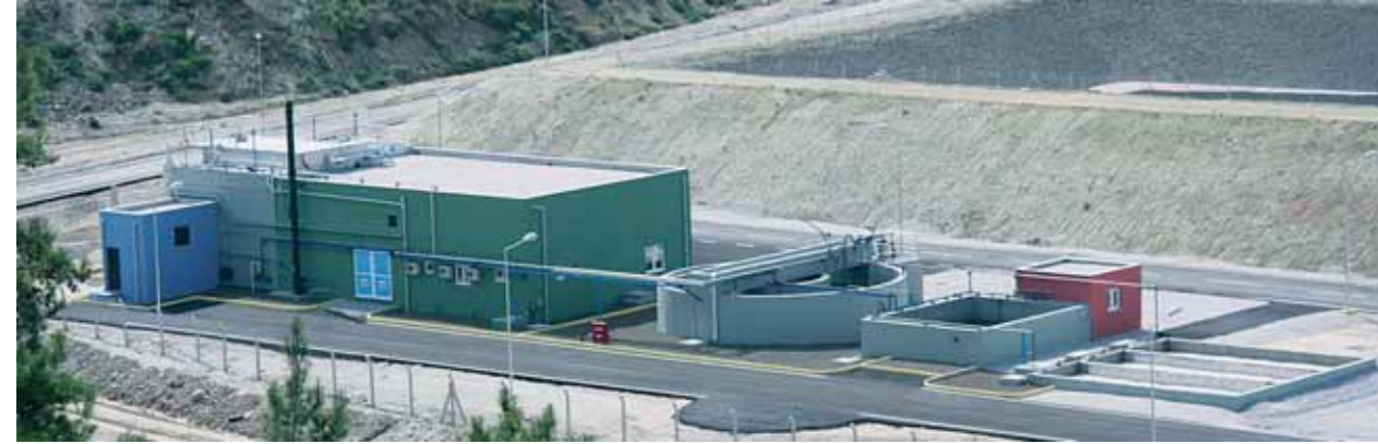
Çanakkale Çöp Depolama Sahası Sızıntı Suyu Arıtma Tesisi, Çanakkale - Türkiye Kapasite: 80 m 3 /gün, KOL Yüğü: 918 kg/gün
