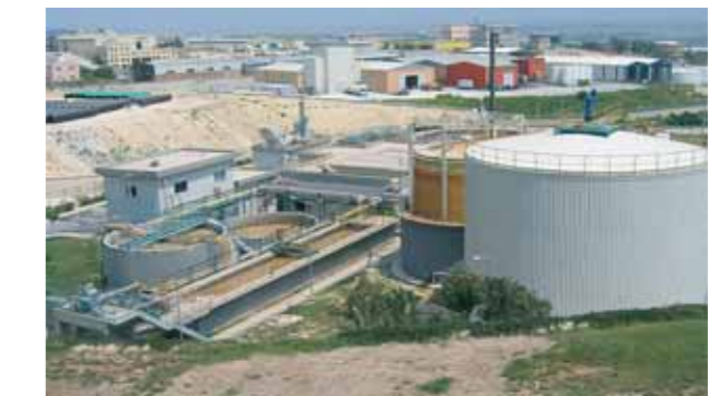
Pepsi Co Gıda - Frito Lay Atık Su Arıtma Tesisi, Tarsus - Türkiye Kapasite: 900 m 3 /gün, KOİ Yüku: 9.000 kg/gün
