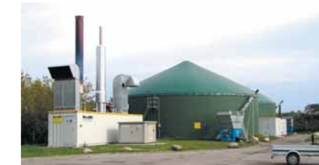
400 kWe Biyogaz Tesisi (Büyükbaş hayvan ve enerji bitkisinden)
