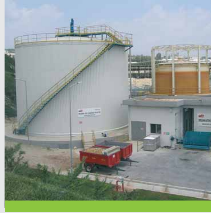
Pepsi Co Gıda - Frito Lay Tarsus Katı Atık Arıtma Tesisi (40.000 ton/yıl; 500 kWe)
