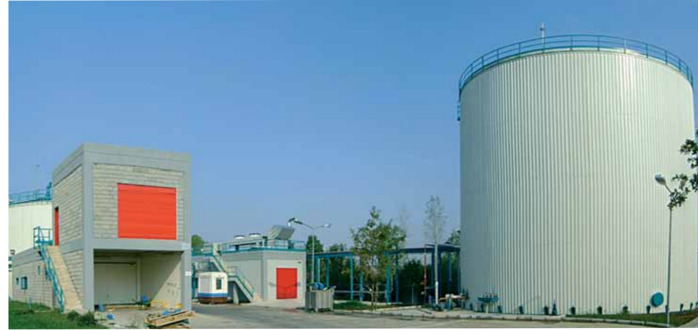
Pepsi Co Gıda - Frito Lay İzmit Katı Atık Arıtma Tesisi (50.000 ton/yıl; 650 kWe enerji)
