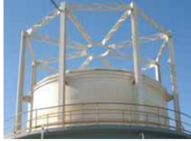
Yüzer tip biyogaz deposu
