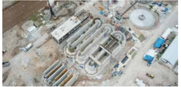
Şekil 6. Elbistan Atıksu Arıtma Tesisi - Türkiye
