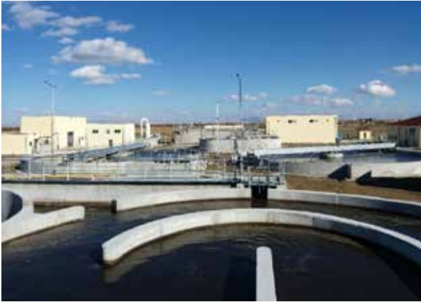
Şekil 4. Akşehir Atıksu Arıtma Tesisi -Türkiye
