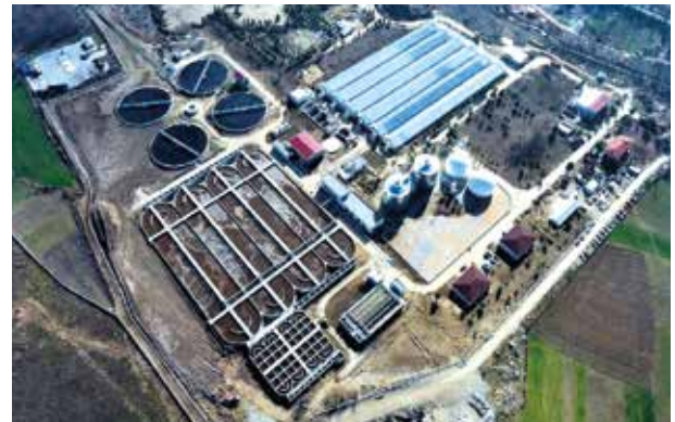
Şekil 2. Kütahya Atıksu Arıtma Tesisi -Türkiye
