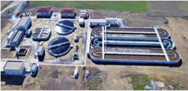
Şekil 3. Akşehir Atıksu Arıtma Tesisi -Türkiye
