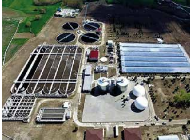
Şekil 1. Kütahya Atıksu Arıtma Tesisi -Türkiye
