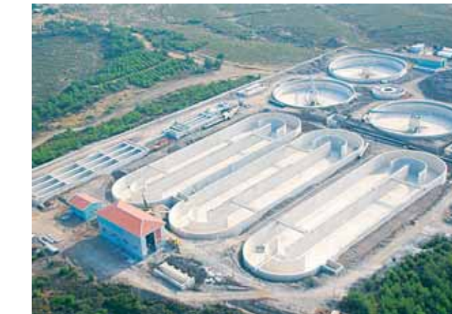
Küçükköy Belediyesi Atık Su Arıtma Tesisi, Türkiye Kapasite: 49.512 m 3 /gün (150.000 E.N.) Prosesler: Fiziksel Arıtma - Biyolojik Arıtma - Çamur Susuzlaştırma - Gaz Klorlama
