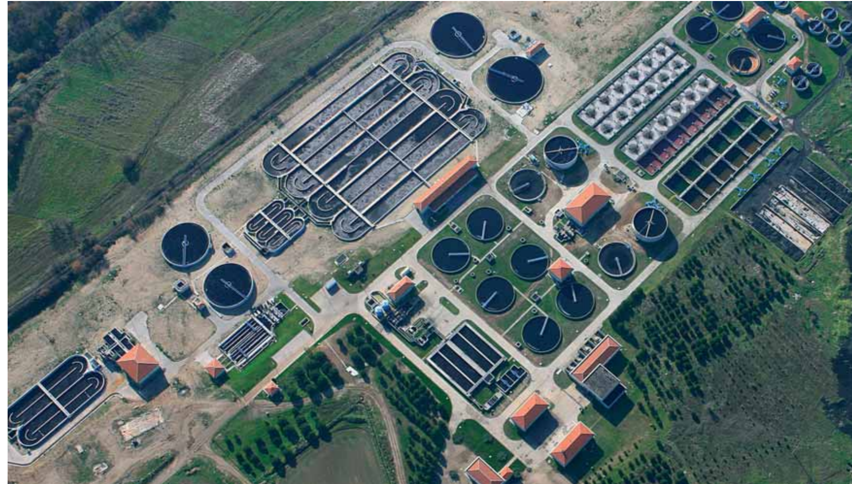
Çerkezköy OSB Atık Su Arıtma Tesisi, Türkiye Kapasite: 80.000 m 3 /gün fiziksel arıtma, 40.000 m 3 /gün biyolojik arıtma (470.000 E.N.)
