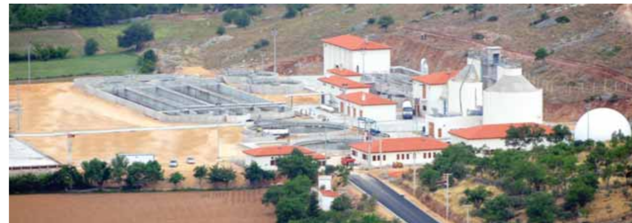
Muğla Belediyesi Atık Su Arıtma Tesisi, Türkiye Kapasite: 17.111 m 3 /gün (100.000 E.N.) Proses: Fiziksel Arıtma - Biyolojik Arıtma - Çamur Cürütme - Çamur Susuzlaştırma
