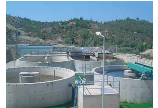
Güllük Belediyesi Atık Su Arıtma Tesisi, Türkiye Kapasite: 2 x 2.000 m 3 /gün (10.000 E.N.) Proses: Fiziksel Arıtma - Biyolojik Arıtma - Çamur Susuzlaştırma
