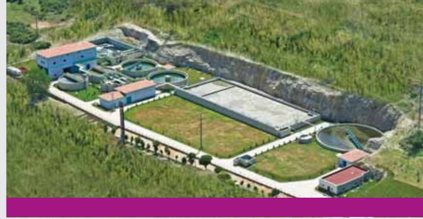
Dilovası O.S.B Atık Su Arıtma Tesisi, Türkiye Kapasite: 21.144 m 3 /gün (111.650 E.N.), KÖI yükü: 13.398 kg/gün Proses: Biyolojik Arıtma - Kimyasal Arıtma - Çamur Susuzlaştırma - Çamur Kurutma YİD Projesi: 2 yıl inşaat - 27 yıl işletme
