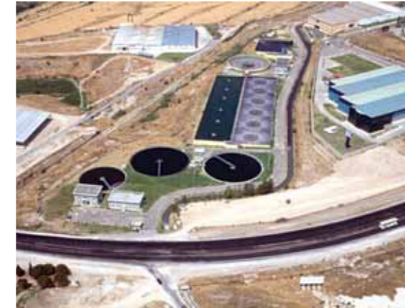
Denizli Organize Sanayi Bölgesi (OSB) Atık Su Arıtma Tesisi, Türkiye Kapasite: 42.000 m 3 /gün (350.000 E.N.)
